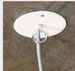
Коробка КВТ... закрытая крышкой V 68 S с выведенным проводом и люстровым крюком KBP...
