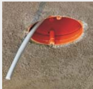
Коробка КВТ... с выведенным проводом, готовая для установки люстрового крюка KBP...
