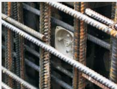
Крышка KBV, прикрепленная на опалубке.
