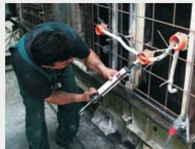
Герметизация вводов (шпатлёвка).
