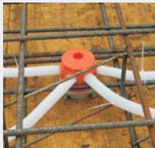
Пример использования в горизонтальной опалубке.
