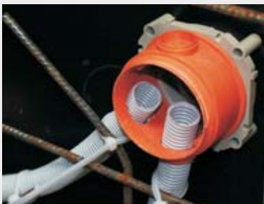
Смонтированные гибкие трубки в корпусе КВТ.
