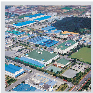
Завод в Чэонгжу (Корея)
