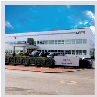
Завод в Даляне (Китай)
