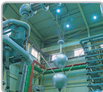
Испытание импульсом в лаборатории высоких напряжений
