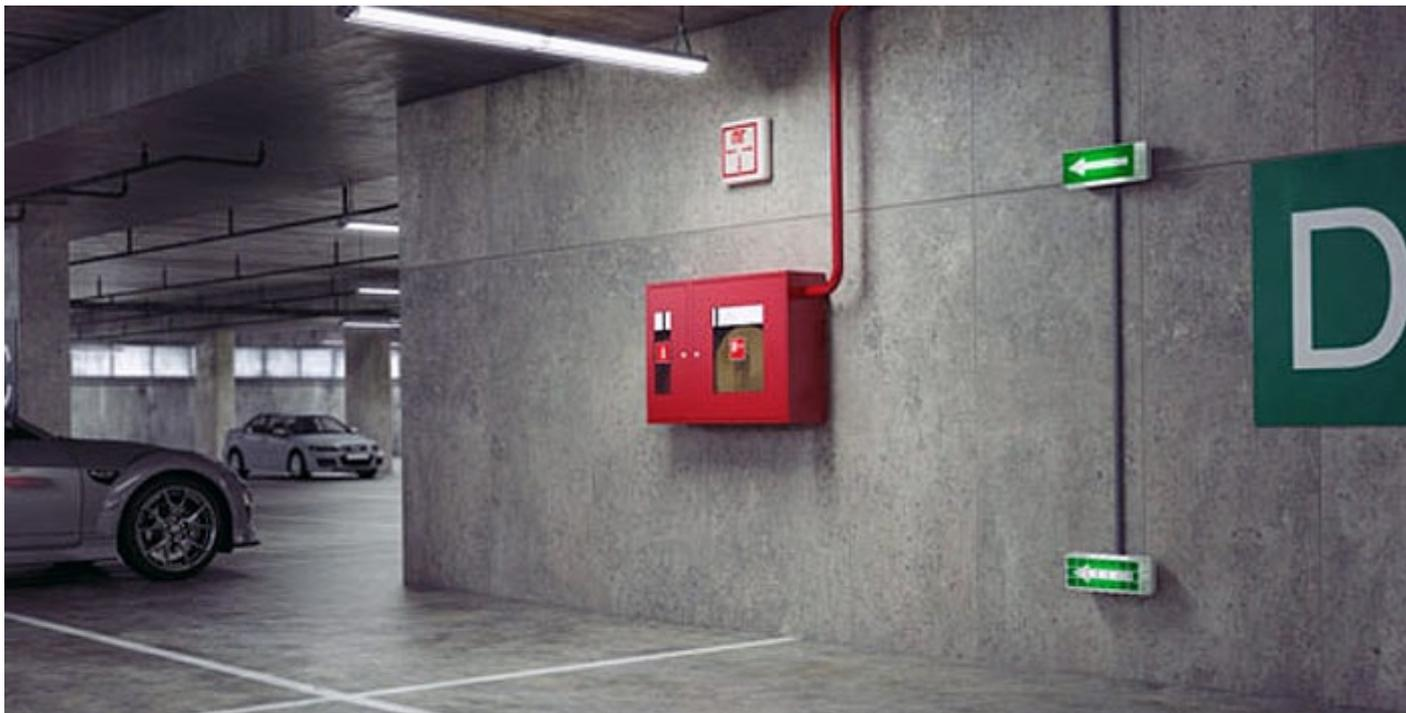
Предназначены для указания мест выхода при эвакуации, направления движения, а также для различных информационных целей. Практически любое общественное помещение должно быть оборудовано светильниками аварийного освещения «ВЫХОД». Светильники «ВЫХОД» применяются в больницах, офисах, магазинах, административных зданиях, производственных цехах, школах, университетах, кинотеатрах, и многих других производственных и общественных помещениях.
